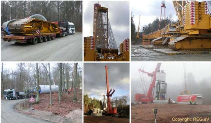
*Bild (von oben links nach unten rechts): Riesenkran mit Anlieferung Raupenteil, Flaschenzug, fertig montiertem Ausleger (ca. 130 m); Anlieferung Turmsegment mit Allrad-Lkw vorne ziehend und Transport-Lkw rückwärts schiebend; auf dem nördlichen Bauplatz weißer Montagekran und roter 500t-Kran; im Nebel 500t-Kran setzt Maschinenhaus ab, mittig Transformator in 3 Ebenen im Turminnern*
